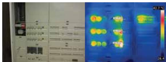
Cette image thermique montre que la charge en exploitation est inégalement répartie sur les boîtiers de fusibles.
